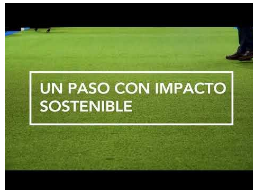
Instalación césped artificial
